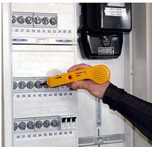
Traženje odgovarajućeg osigurača za određeni strujni krug
