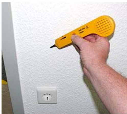
Traženje prekida vodiča u kablu ispod žbuke
