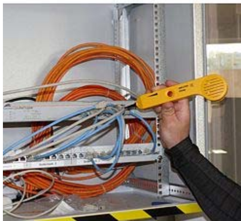
Traženje kabela na HUBu
